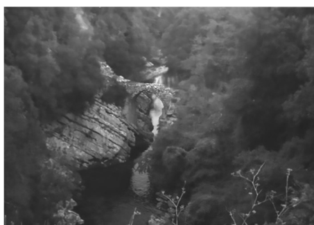
Fig. 2 -Foto Alma Carrano: il ponte a sella d'Asino sul fiume Calore
